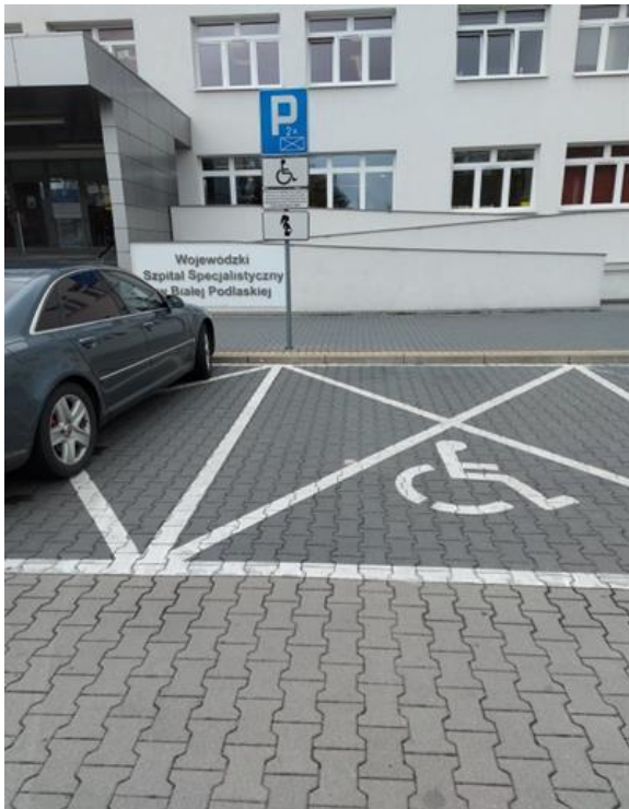
Fot. 2. Złe oznakowanie poziome miejsc parkingowych dedykowane osobom z niepełnosprawnością
